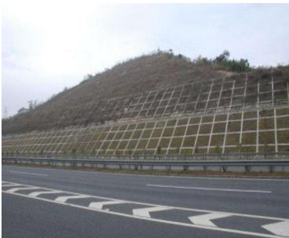
高速公路护坡锚杆案例示意图 1
