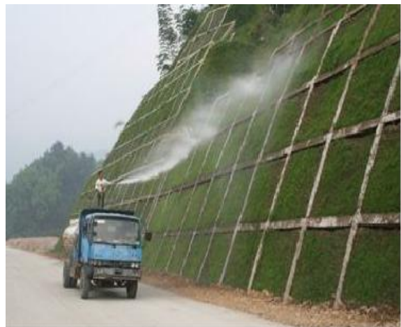
高速公路护坡锚杆案例示意图 2
