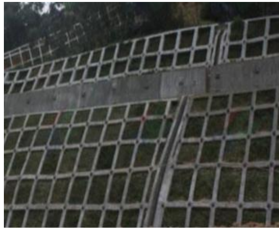
山坡支护锚杆案例示意图 2
