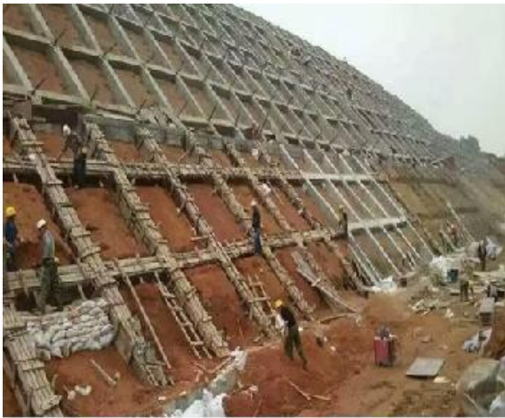
山坡支护锚杆案例示意图 1
