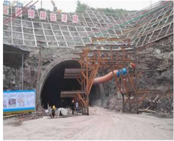
隧道边坡支护锚杆案例示意图 2
