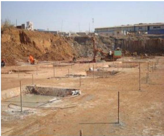
地下室抗浮锚杆案例示意图 1
