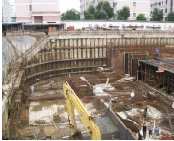
基坑支护锚杆案例示意图 2
