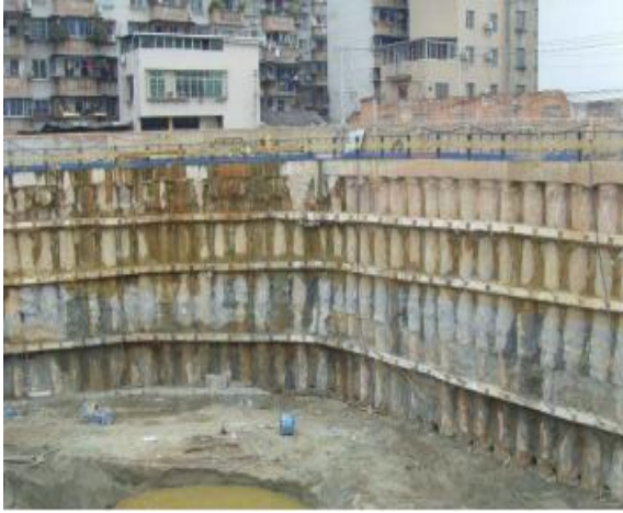
基坑支护锚杆案例示意图 1
